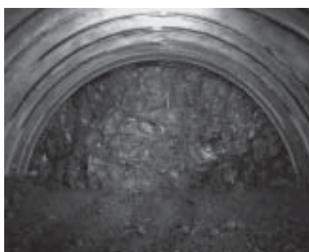
トンネル内切羽状況
