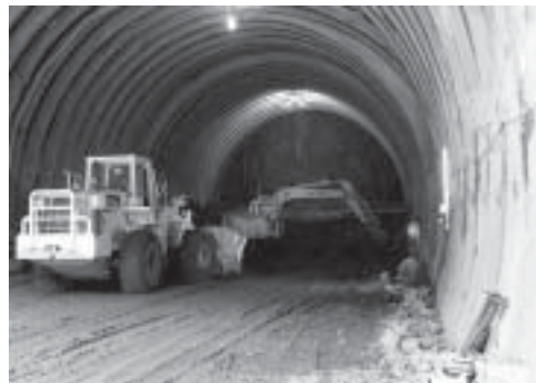
トンネル内掘削作業の様子
